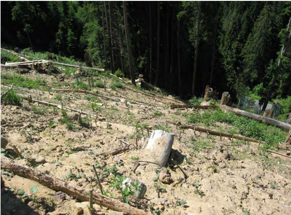
Fotostandort 13: Aufnahme der verbauten Rutschfläche. Wie entwickeln sich die gepflanzten Weidenstecklinge und die Erlen? 04.07.2011
