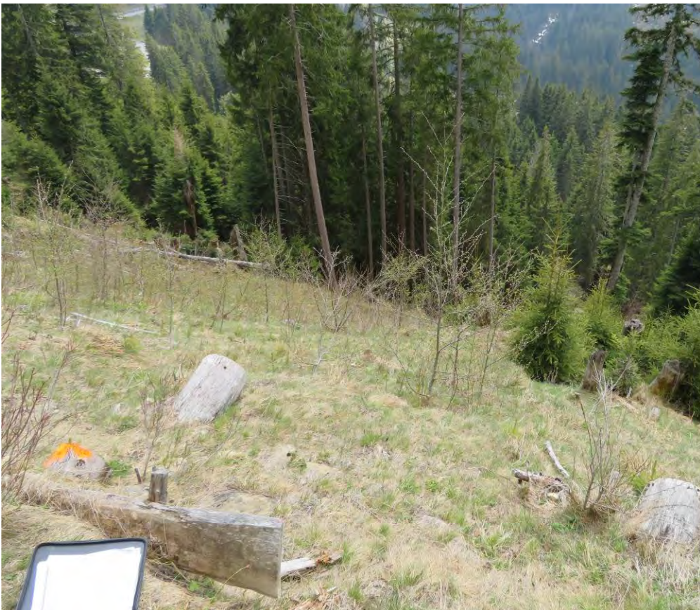
F13: Gepflanzte Erlen und Weiden haben sich auf der Rutschfläche gut etabliert. Rutschfläche stabil, 16.05.2019.
