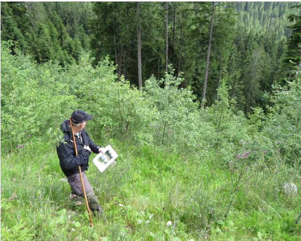
F13: Gepflanzte Erlen und Weiden haben sich auf der Rutschfläche gut etabliert. Rutschfläche stabil, 14.07.2021
