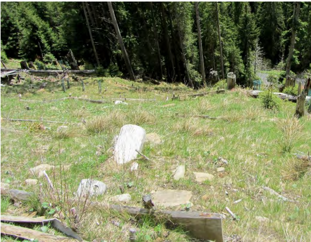
F13: Aufnahme der verbauten Rutschfläche. Ausgetriebene Weidenstecklinge und Erlen auf der Fläche anzutreffen (0.4 bis 0.8 m gross)
