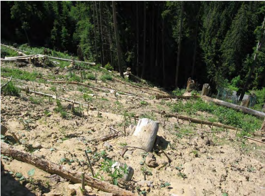
Fotostandort 13: Aufnahme der verbauten Rutschfläche. Wie entwickeln sich die gepflanzten Weidenstecklinge und die Erlen?
