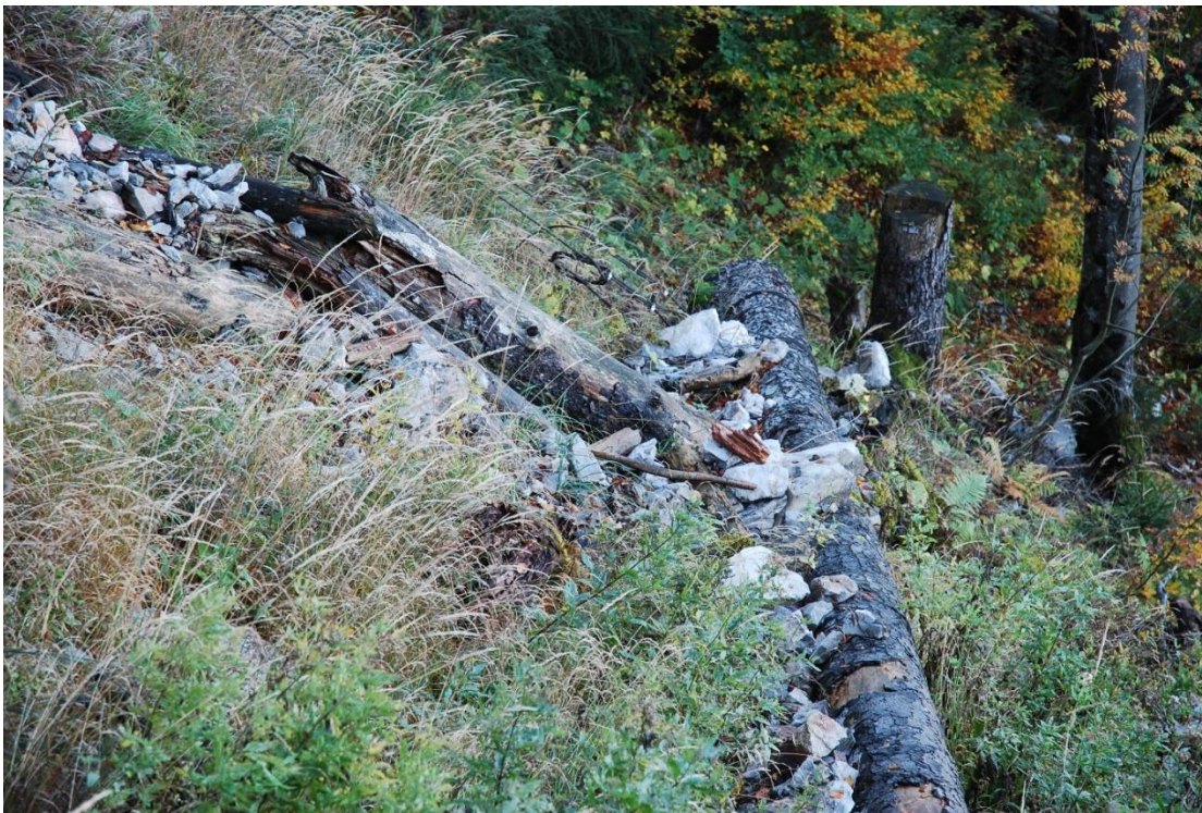
Steinschlagabweiser Nr. 6 von 2015.
